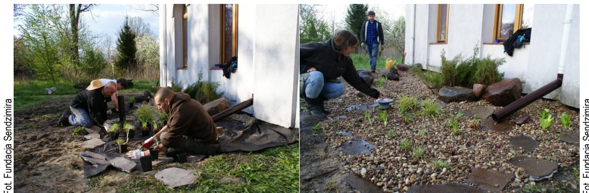
Budowa ogrodu deszczowego w gruncie przy siedzibie Stowarzyszenia „On Ja Ty” w Bukowcu
