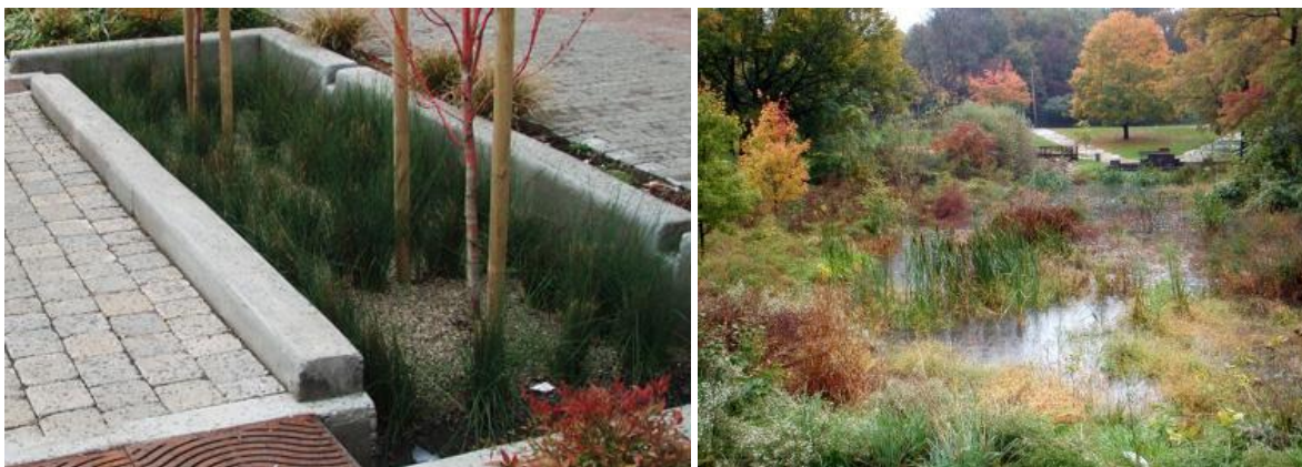
Przykłady obiektów zielonej infrastruktury instalowanych w Filadelfii: zielona mini niecka filtracyjna (po lewej), oczyszczalnia hydrofitowa wód deszczowych o zwierciadle swobodnym (po prawej)
