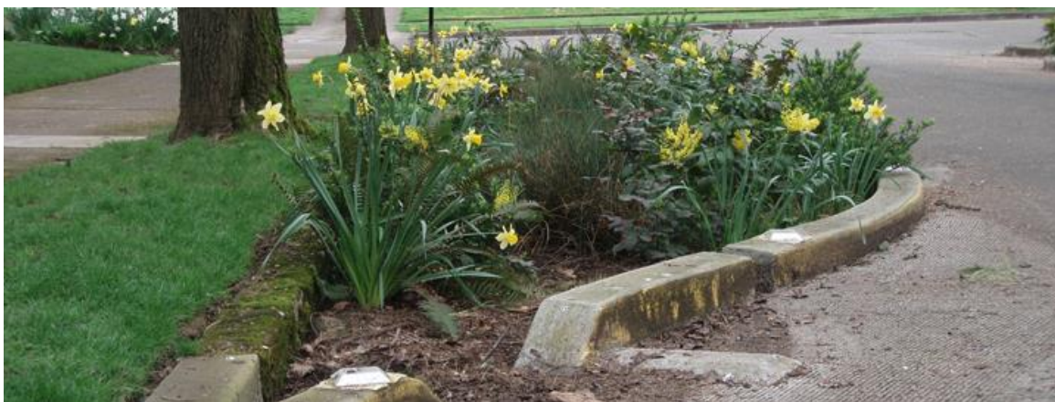
Wysepka spowalniająca ruch, służąca również jako element retencji i podczyszczania wód deszczowych spływających z jezdni
