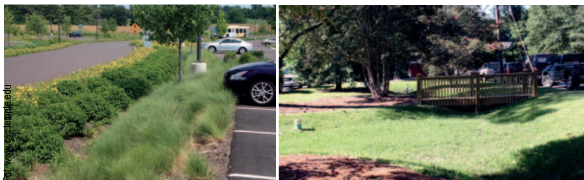
Płytki niecka infiltracyjna przy parkingu szpitalnym w Norriton, USA (po lewej). Buforowy pas trawiasty w połączeniu z niecką w Aiken, USA (po prawej)
