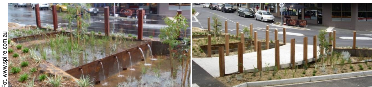
Pasaż roślinny oczyszczający wody deszczowe z drogi przed ich odprowadzeniem do rzeki Plenty, Banyule, Australia
