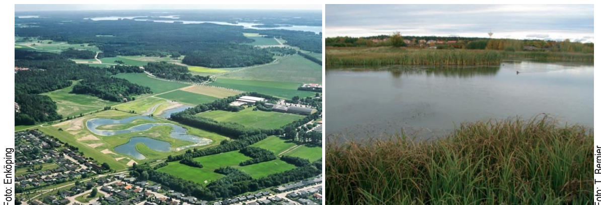
Oczyszczalnia hydrofitowa przyjmująca większość wód deszczowych i roztopowych z miasta Enköping w Szwecji: widok ogólny po ukończeniu budowy, przed obsadzeniem roślinnością (po lewej), stan obecny (po prawej)
