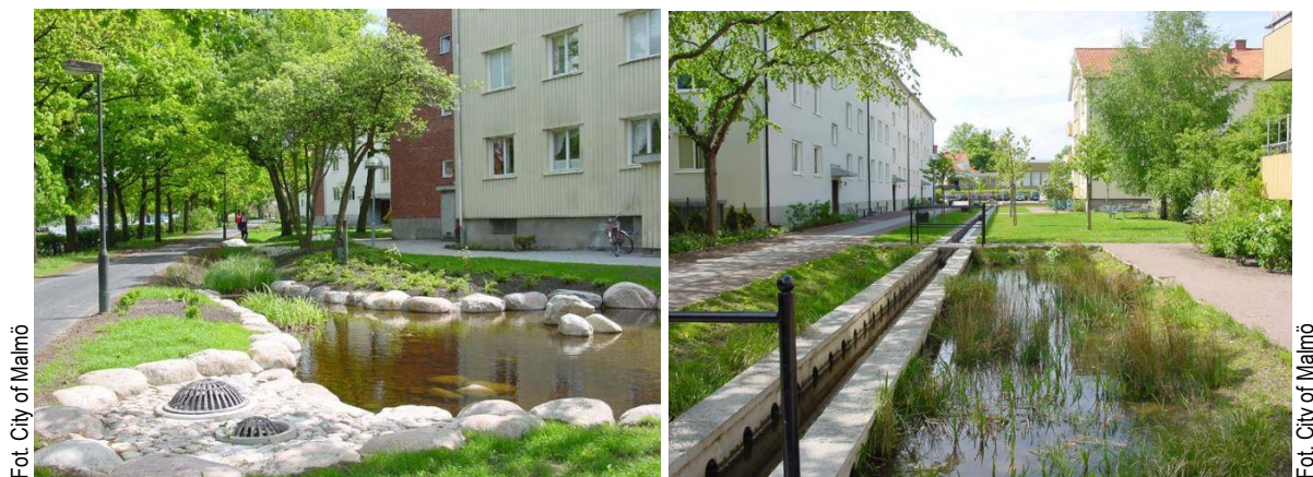
Malmö, Augustenborg: oczko wodne do retencji wody deszczowej (po lewej), kanał deszczowy i przelewy odprowadzające nadmiar deszczu na teren zalewowy (po prawej)
