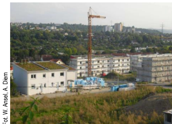
Budowa osiedla Hohlgrabenäcker: wielorodzinne budynki z obligatoryjnymi zielonymi dachami (po lewej) i przepuszczalna nawierzchnia chodników (po prawej)
