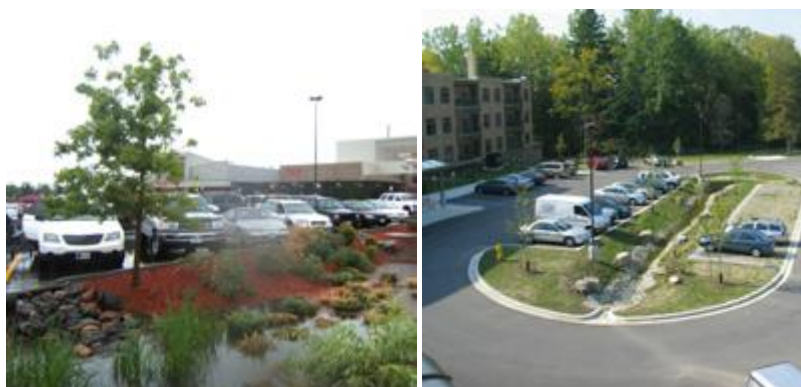
Fot. 173, 174, 175. Niecki chłonne obsadzone roślinnością, źródła fot.: UACDC, Low Impact Development: a design manual for urban areas . Fay Jones School of Architecture, University Of Arkansas Press, Fayetteville, 2010.
