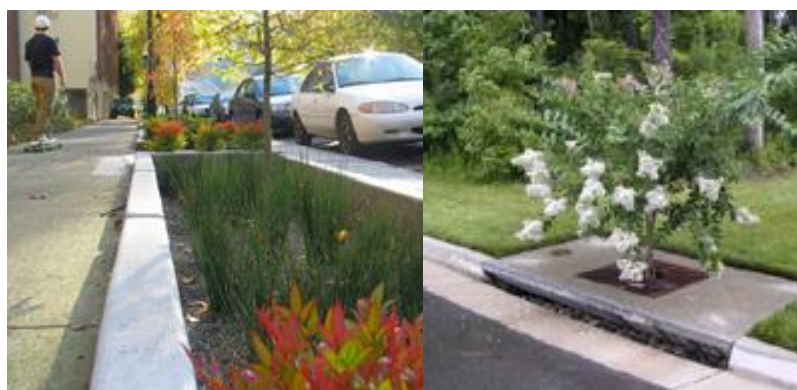
Fot. 181 i 182. Kieszonkowe niecki chłonne ( pocket wetlands ) i donice przyuliczne, źródła fot. : UACDC, Low Impact Development: a design manual for urban areas . Fay Jones School of Architecture, University Of Arkansas Press, Fayetteville, 2010.
